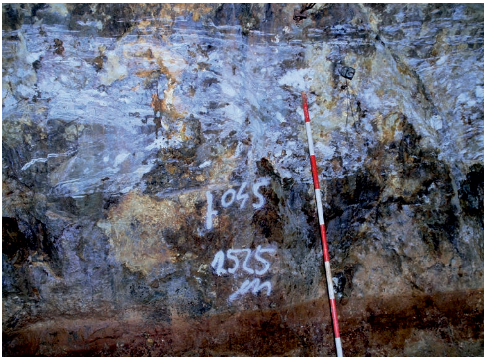
2. ábra: Breccias ércetelér feltárása a gyöngyösoroszi altáró 1525 folyóméterében.
